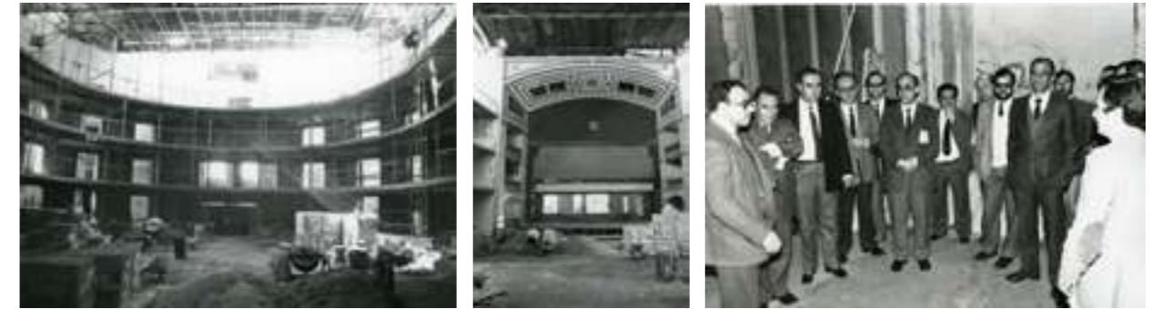
Diversos aspectos del Gran Teatro durante el desarrollo de las obras. Vista del interior del Gran Teatro durante el desarrollo de las obras, que depararon algunas sorpresas, como relata Herminio Trigo en sus memorias. Aspecto del patio de butacas convertido ocasionalmente en zona de obras, caja del escenario y techo desmontado que deja ver vigas y tablas. Y visita a las obras de concejales, técnicos y dirigentes de cajas de ahorros; a la izquierda del grupo el arquitecto director de la intervención José Antonio Gómez-Luengo. Fotos R. Mellado, 1985. Archivo Municipal de Córdoba
