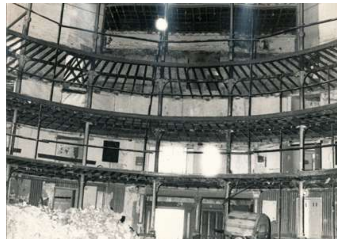
Estructura de los anfiteatros al comienzo de las obras en 1983. Foto: Paloma. Archivo Municipal de Córdoba.
