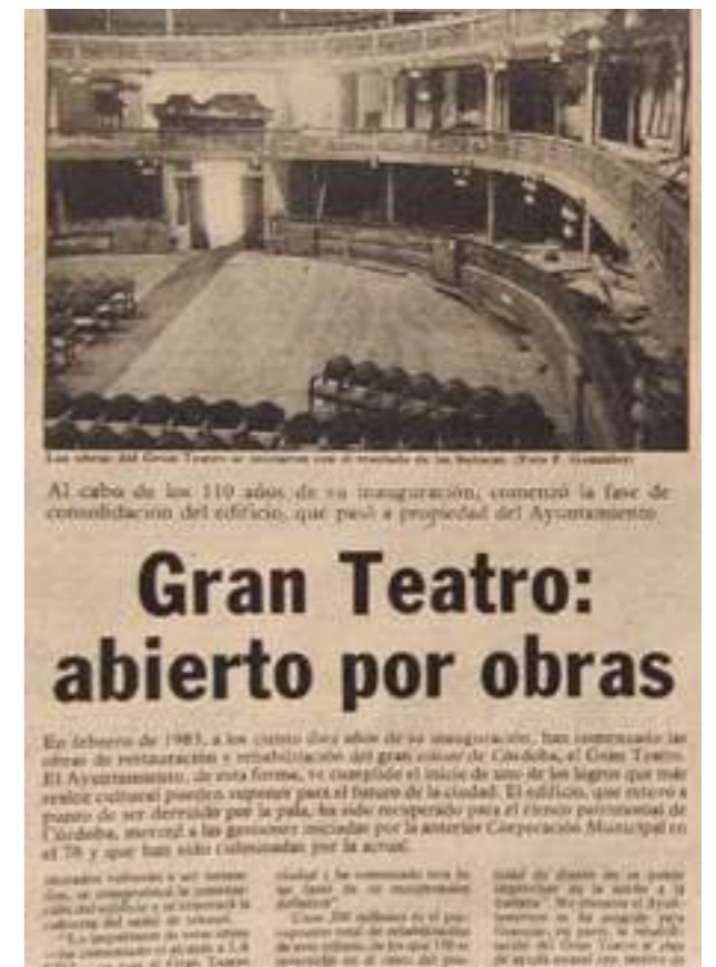
Crónica periodística del inicio de las obras en el Gran Teatro. Diario La Voz de Córdoba , 10.02.1983
