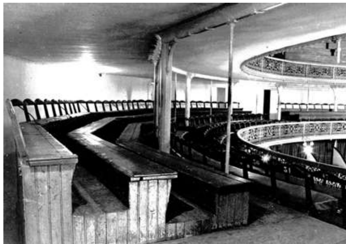
En la imagen pueden apreciarse los puntales de refuerzo de las vigas antes de la restauración del Teatro. Foto: Ladis. Archivo Municipal de Córdoba.
