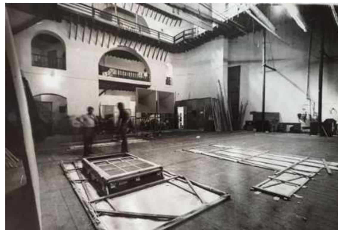
Vista general del cubo escénico al inicio de las obras. Archivo Municipal de Córdoba.
