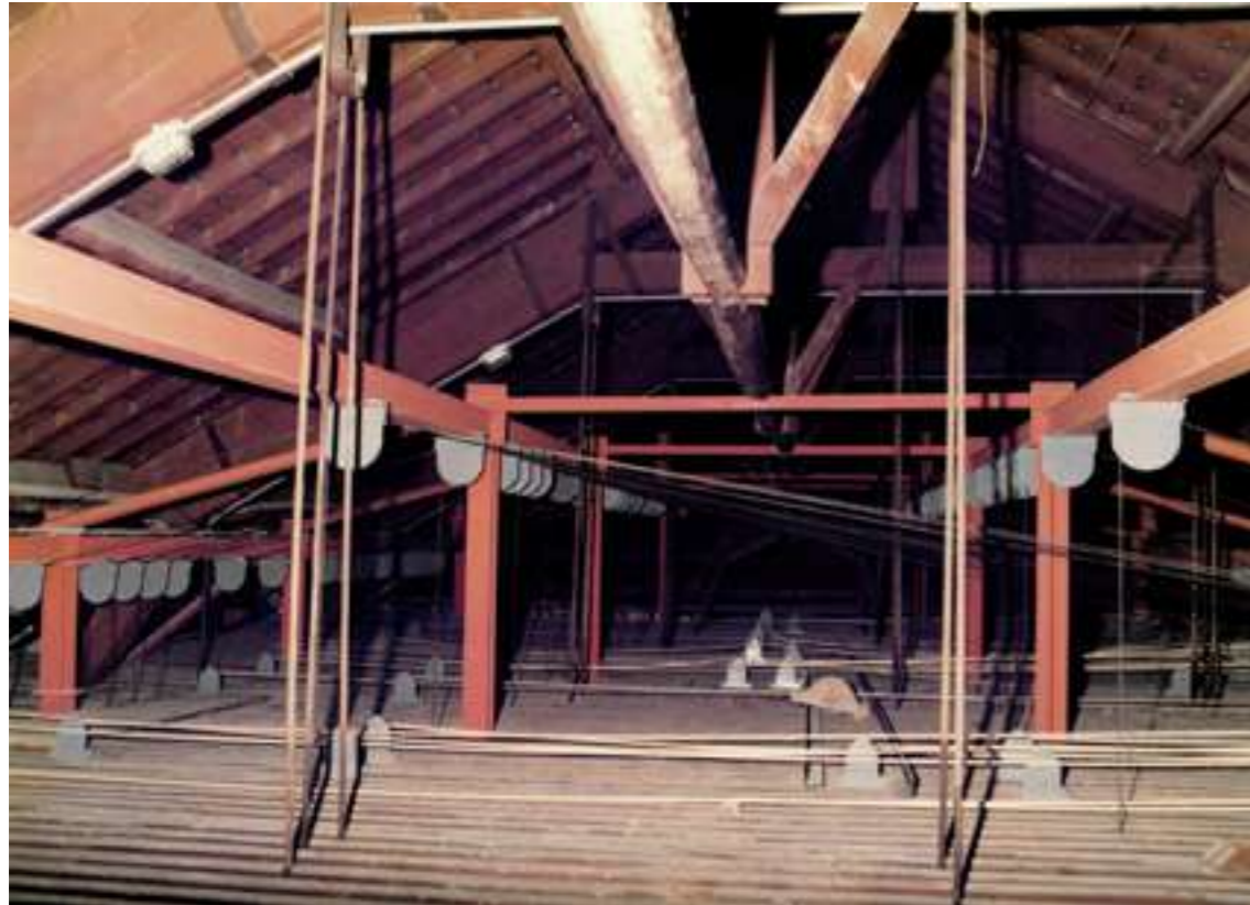
Estructura introducida para las poleas de la tramoya. Foto: Ladis. Gran Teatro.
