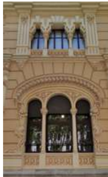
Detalle exterior del Colegio de Arquitectos de Córdoba, institución profesional que impugnó el fallo del concurso de anteproyectos y que el Ayuntamiento desestimó. Foto: FSM, 2023
