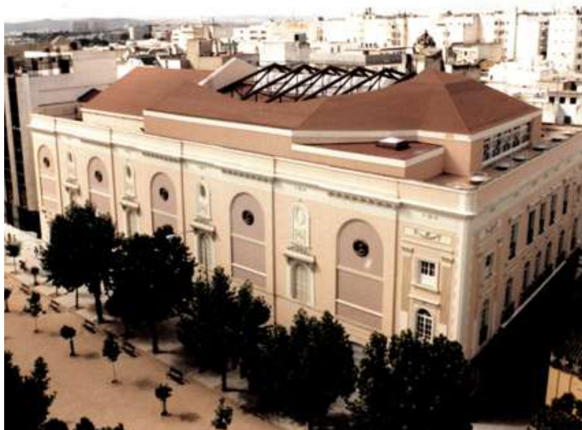
Fachadas tras la restauración. Foto: Tejederas. Gran Teatro.
