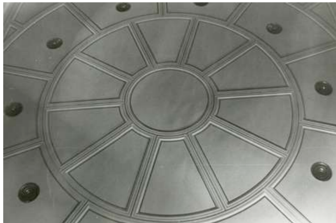
Nuevo techo de la Sala del público. Foto: Ladis. Archivo Municipal de Córdoba.
