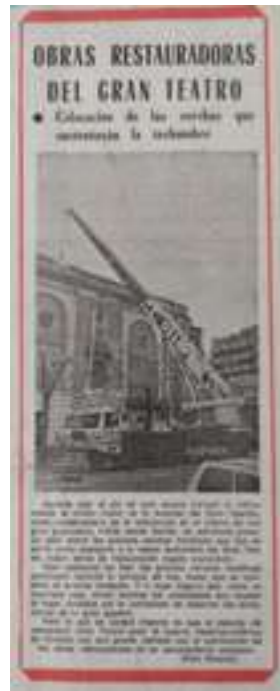
Grúa hidráulica gigante para subir a la cubierta las grandes cerchas metálicas. Diario Córdoba, 03.04.1984
